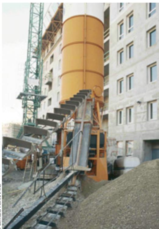
Nouvelle centrale à béton
