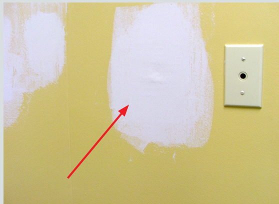
Altération sur un mur de plâtre recouverte d'un composé à joints sans sablage et d'un apprêt (prêt à peindre)
