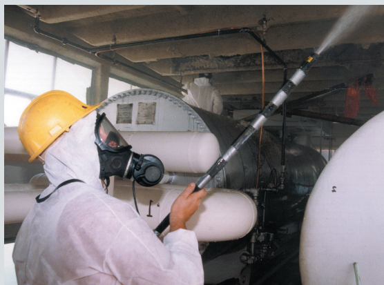
Mouillage en profondeur d'un flocage avant enlèvement
