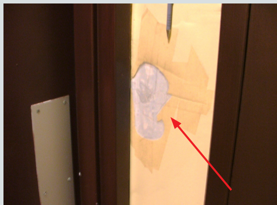
Altération sur un mur de plâtre recouverte d'une pellicule de plastique autocollante et transparente (réparation temporaire)
