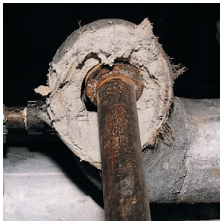
Calorifugeage sur un tuyau
