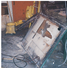
Isolant sur une porte de four
